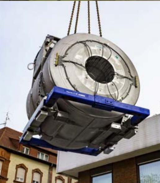
Durch eine Öffnung in der Decke wurde der etwa 20 Tonnen schwere supraleitende Magnet eingebracht. Zu diesem Zeitpunkt wird der Magnet bereits mit flüssigem Helium gekühlt, ist aber noch nicht einsatzbereit.
